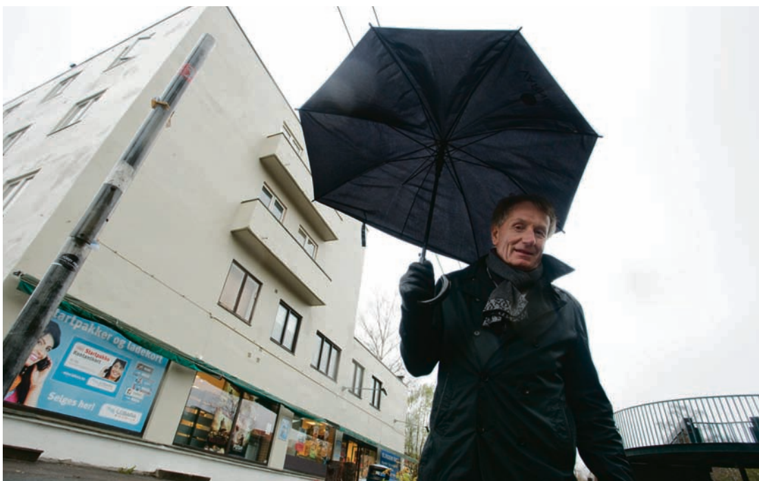
Oppussingsobjekt: Foreløpig har bare fasaden blitt malt, men huset i Apalveien skal oppgraderes. Foreløpig er det åtte leiligheter med plass til i overkant av 30 studenter i bygget, men SiO håper å doble dette antallet.
