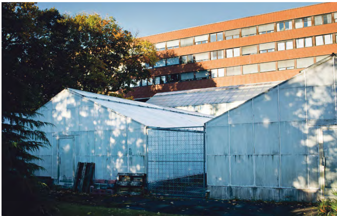
Fytotronen: En defekt vannkran forårsaket en lekkasje i Seksjonen for transgene planter.
