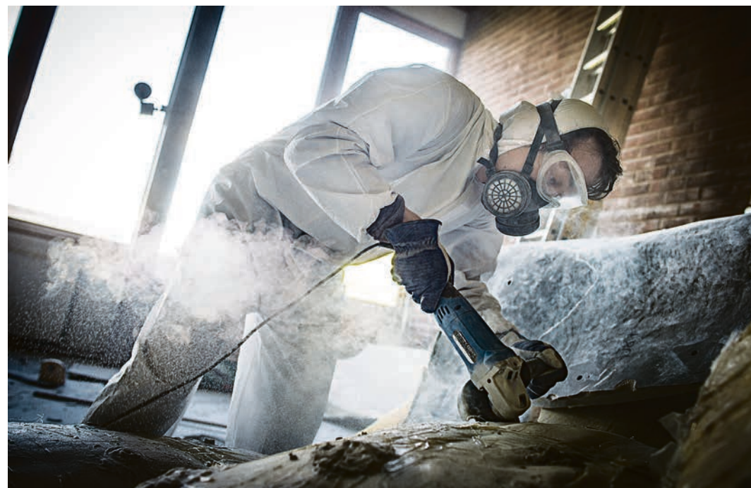
Tear down this wall: David Ringstad, styreleder i OSI klatring, kutter opp restene av den gamle klatreveggen på Blindern. De skal erstattes av nye, moderne vegger. Foreningen har fått noe støtte fra Klatreverket, men står selv bak det meste av finansieringen og arbeidet.
