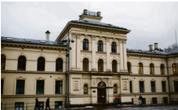
Fremtiden? Dette bygget i St. Olavs gate 32, like ved slottet, huser i dag deler av SiOs helsetjeneste.
