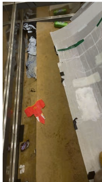
HEISEN: Slik så heisen ut etter studentene flyttet inn i de nye boligene på Nydalen studentby.
