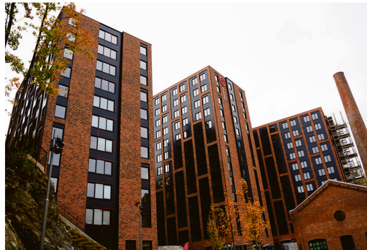
NYDALEN: SiOs nyeste boligsatsing omfatter 478 studentboliger.
