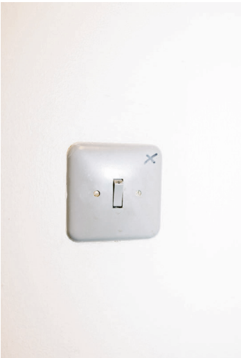
LIGHTS OFF: Er det kanskje mer som skjer på campus når lyset er av?
